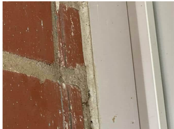
Photo #26 Non-asbestos gray door caulk (HA #28)
