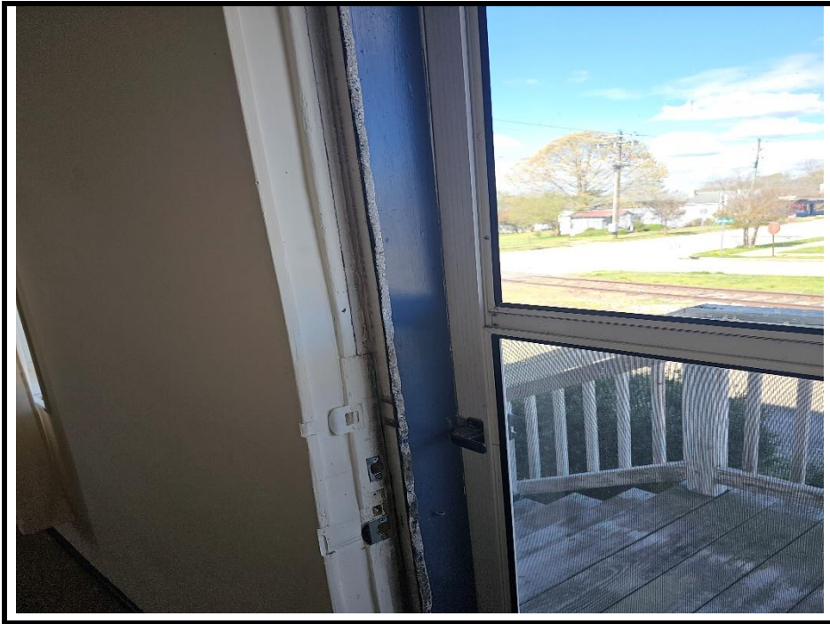
5. Room 5 Blue Door Jamb
